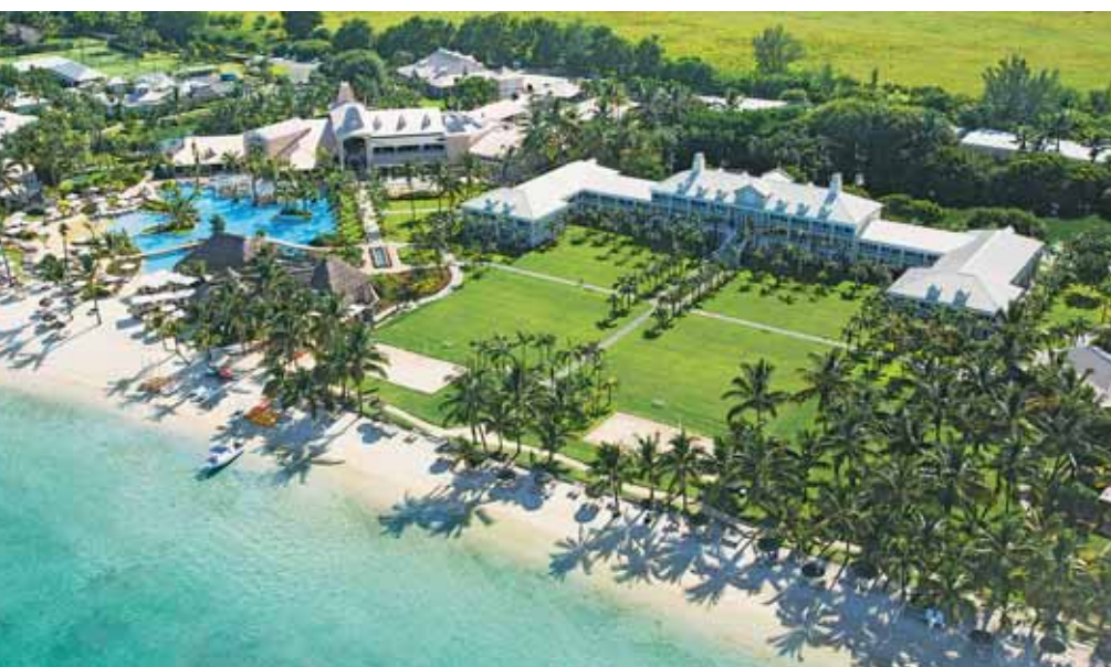
Auf 12 Hektar erstreckt sich das gesamte Areal des Sugar Beach Resort in Flic-en-Flac.
