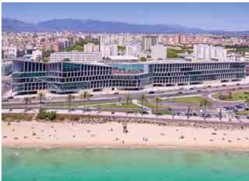
Der Palau de Congressos de Palma und das angeschlossene Vier-Sterne-Superior-Hotel Meliá Palma Bay wurden im April dieses Jahres eröffnet. Alle Fotos: Meliá Hotels International.
