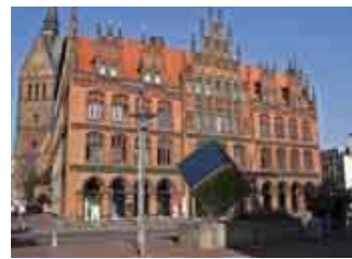
Gemeinsam mit der benachbarten Marktkirche zählt das Alte Rathaus zu den südlichsten Großbauten der Norddeutschen Backsteingotik. Bildquelle: Altes Rathaus Gastronomie Betriebs GmbH
