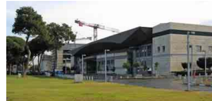
Das Messegelände des ITFCC wird erweitert
