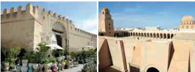
li.: Die Stadtmauer von Kairouan ist komplett erhalten. Foto: B. Brügger re.: Die Große Moschee in Kairouan gehört zu ältesten Gebetshäusern der Welt. Foto: B. Brügger
