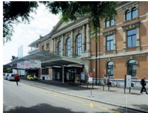
Fit für die Zukunft: Das Kongresshaus am Zürichsee wird instandgesetzt und umgebaut.
